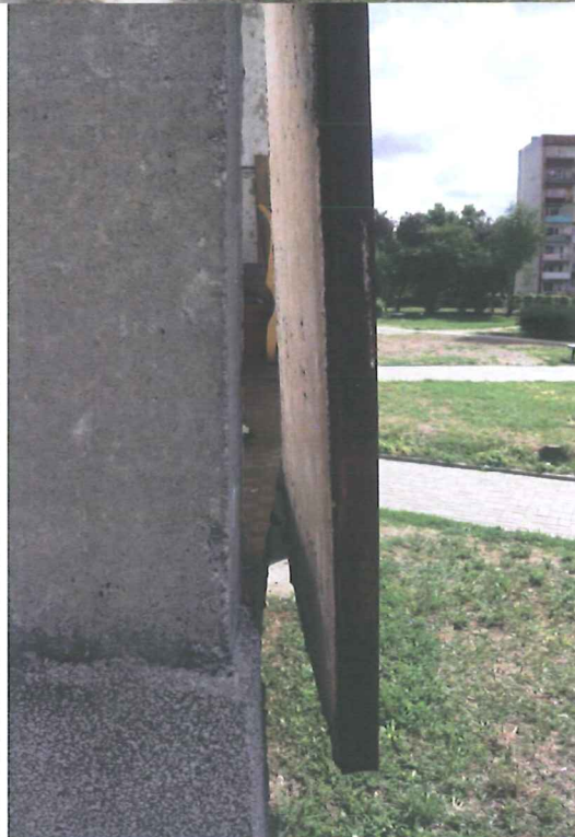
FOT.5.,6. Detale loggii – widoczna korozja elementów metalowych oraz płyty z widocznym zbrojeniem, FOT.7. Płyta balustrady odstaje od loggii.
