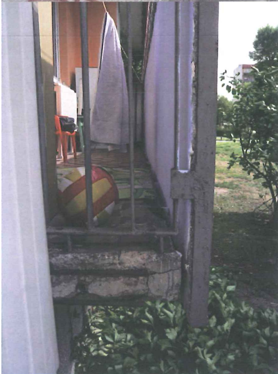
FOT.5.,6. Detale loggii – widoczna korozja elementów metalowych oraz płyty z widocznym zbrojeniem, FOT.7. Płyta balustrady odstaje od loggii.
