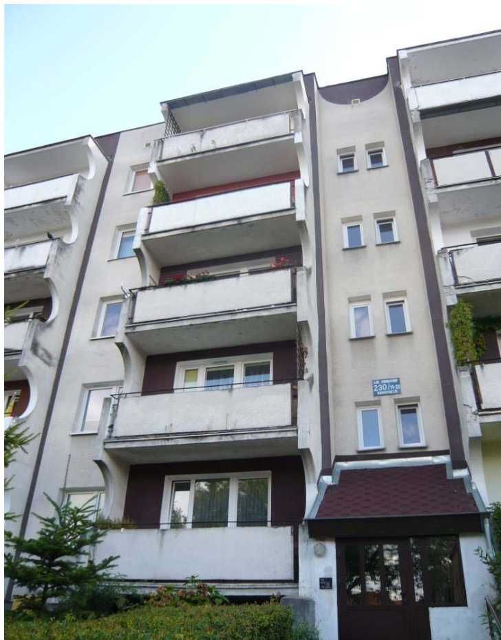
FOT.1. Widok na fragment elewacji z balkonami, balustrady z płyt betonowych .
