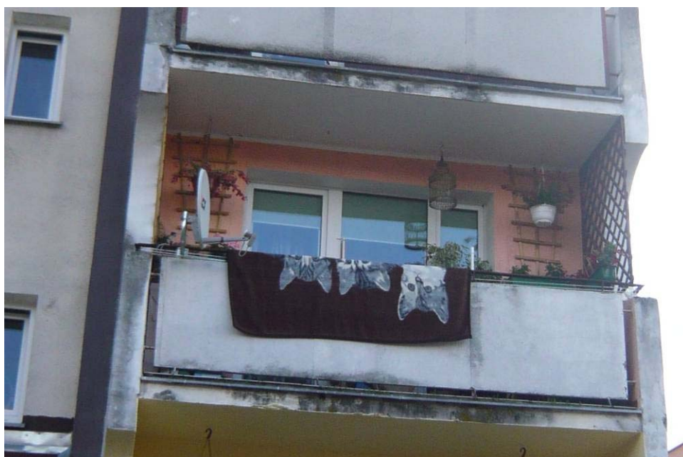
FOT.1. Widok na fragment elewacji z balkonami, balustrady z płyt betonowych .
