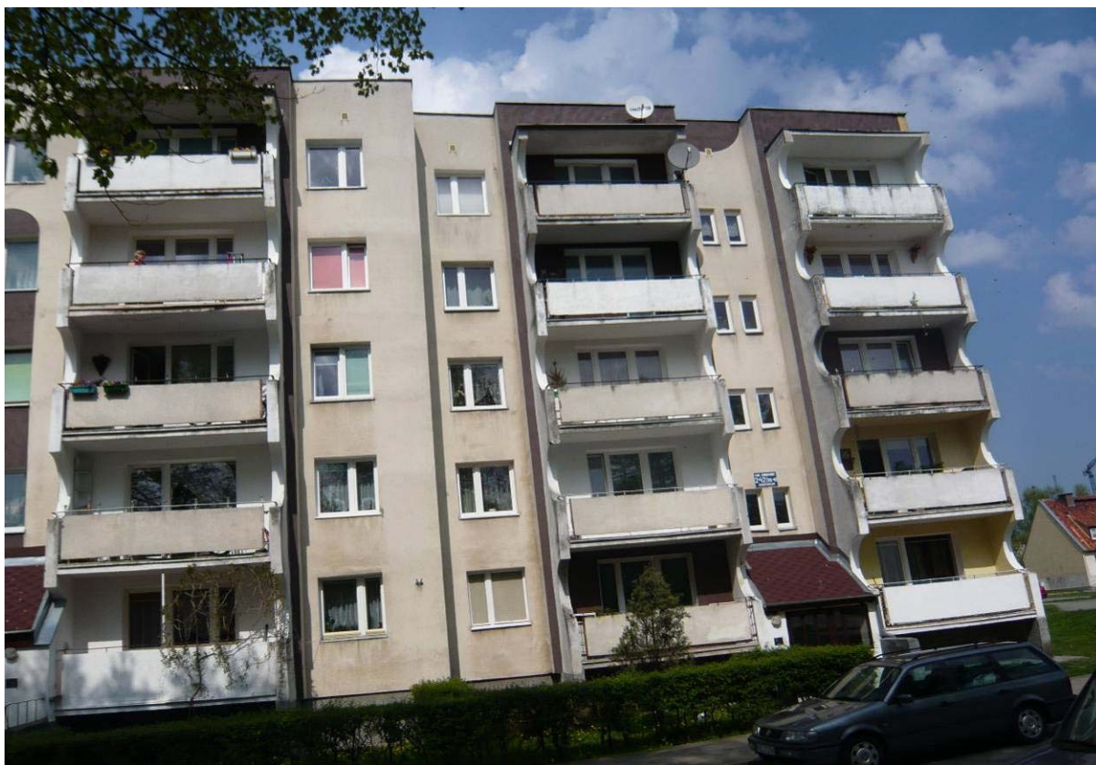
FOT.1. Widok na fragment elewacji z balkonami, balustrady z płyt betonowych .
