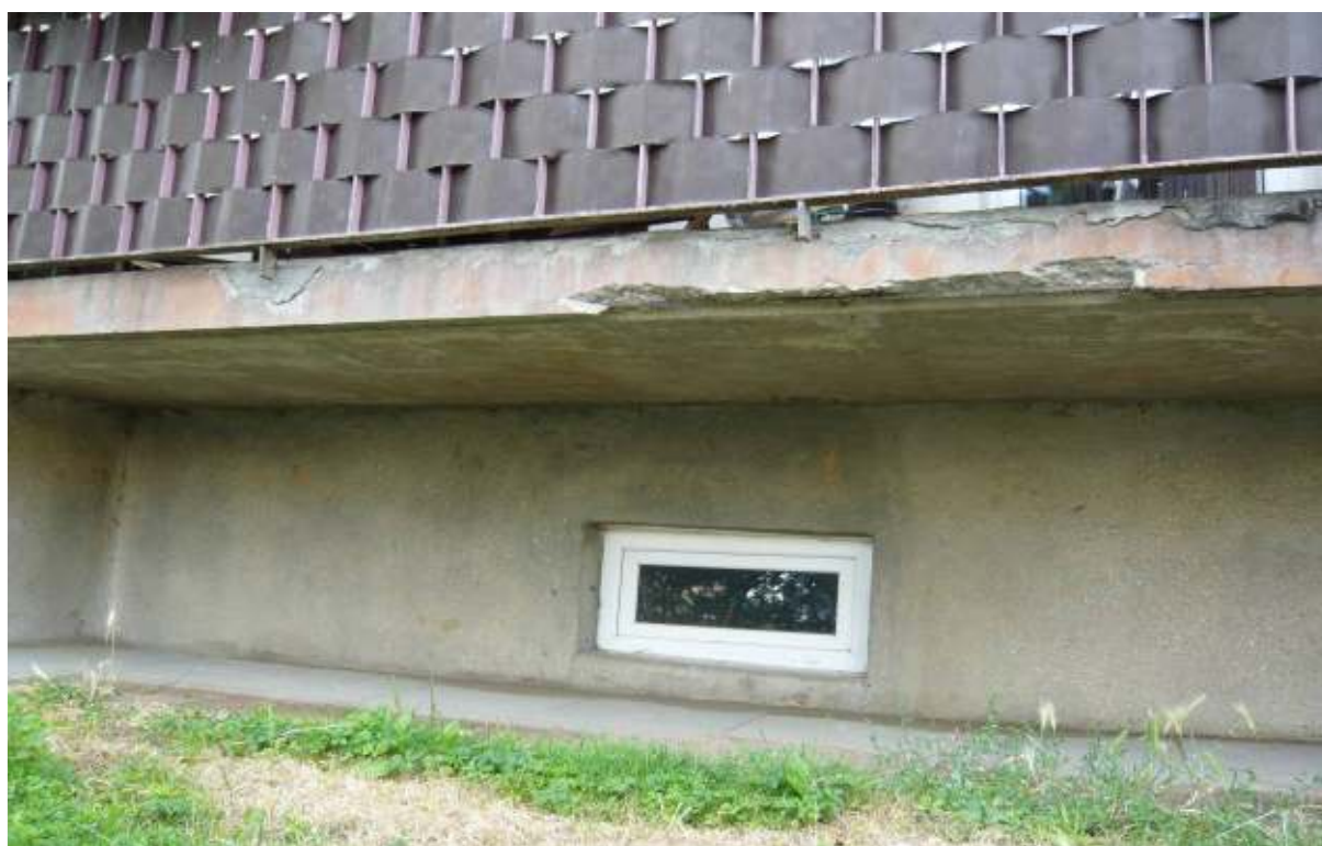
FOT.2. Widok na balkon. Płyta balkonu skorodowana, ubytki w warstwie konstrukcyjnej.
