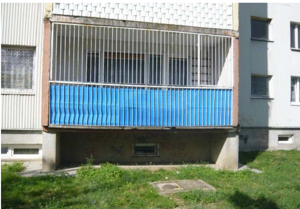
FOT.1.,2. Widok na fragment elewacji z balkonami, balustrady metalowe, ażurowe.
