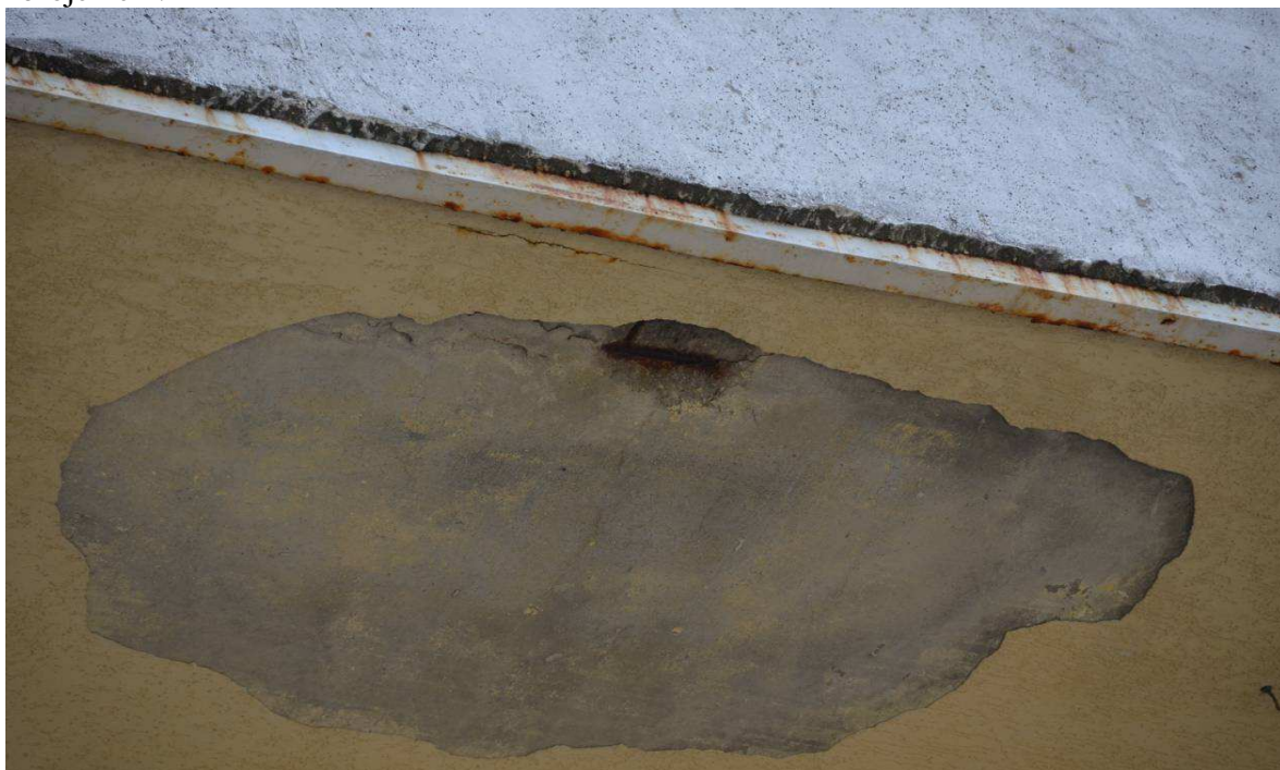
Fot.4. Detal płyty loggii – widoczna korozja spodu płyty z widocznym zbrojeniem.
