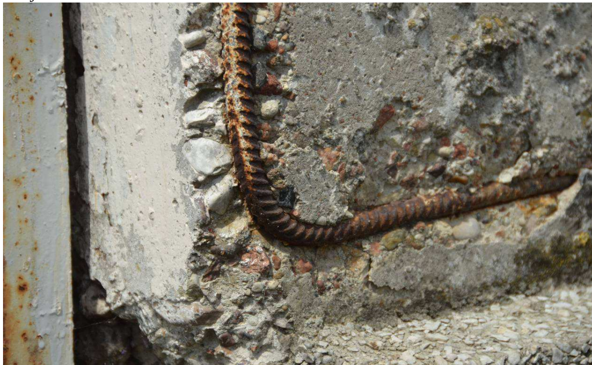
Fot.7. Detal loggi– widoczna korozja elementów metalowych oraz płyty z widocznym zbrojeniem
