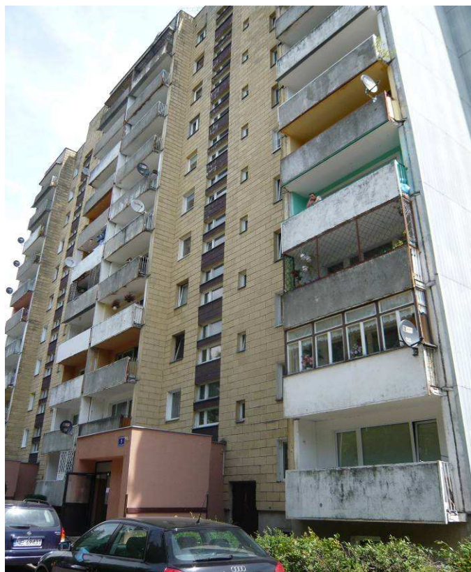
Fot.1. Widok na fragment elewacji z loggiami i balkonami- średni -zły stan techniczny większości balustrad
