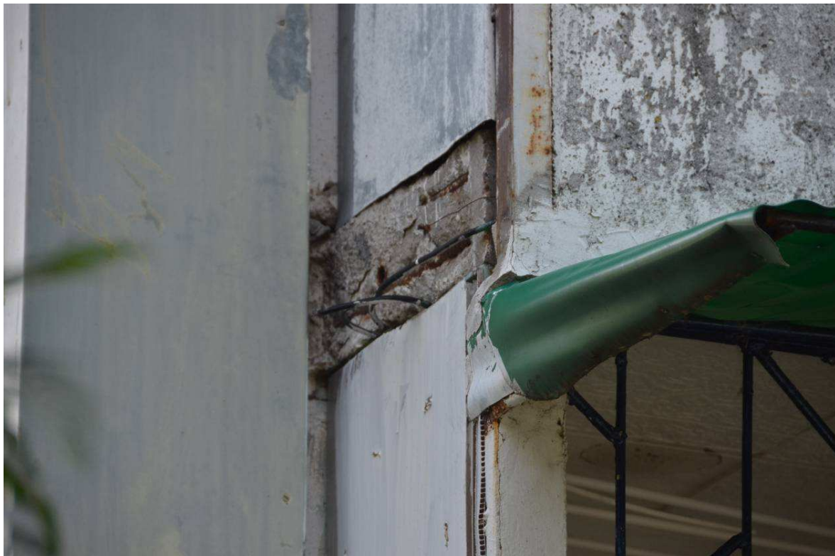
Fot.3. Detal loggii – widoczna korozja elementów metalowych oraz płyty z widocznym zbrojeniem.
