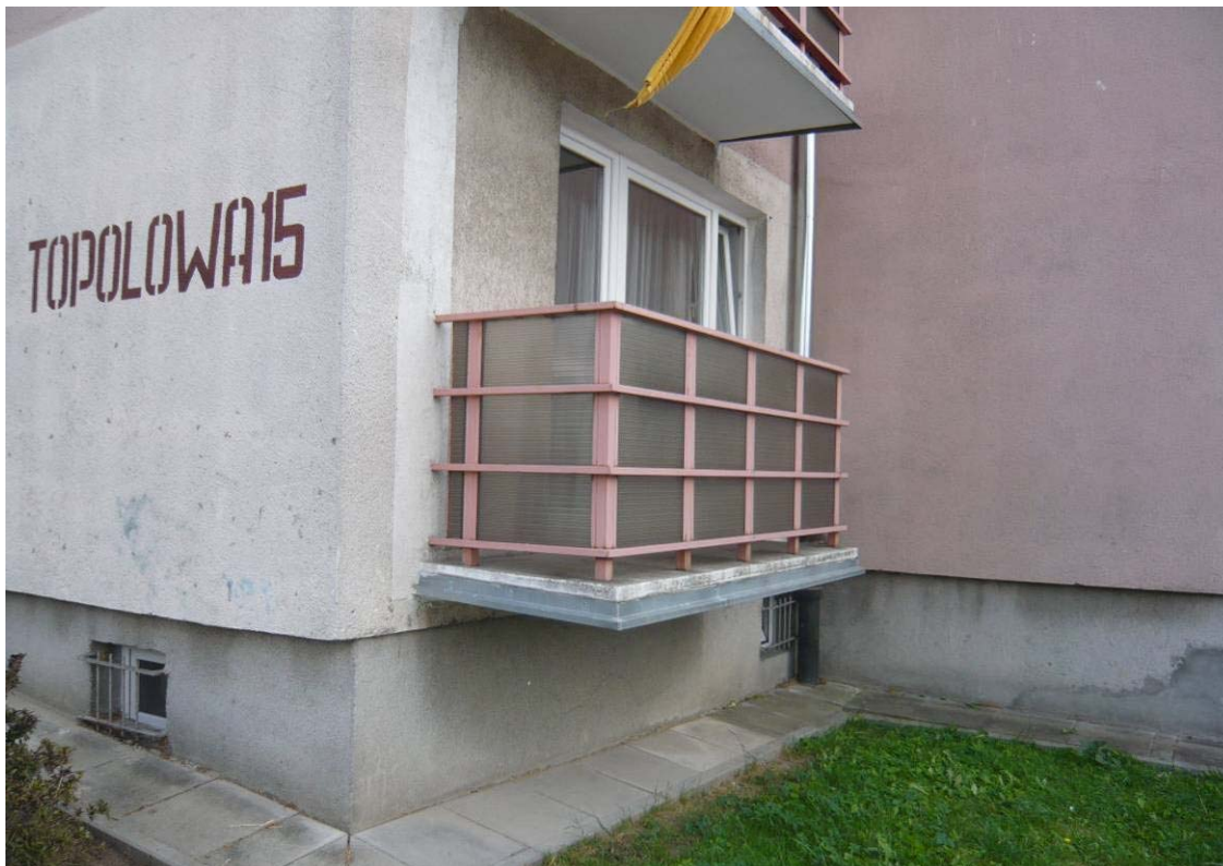
FOT.2. Widok na balkony. Płyta balkonu oraz balustrady w dość dobrym stanie technicznym.
