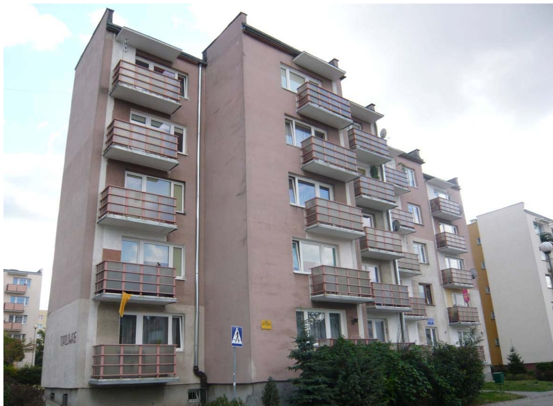
FOT.1. Widok na fragment elewacji z balkonami, balustrady metalowe, z płytą przezierna.
