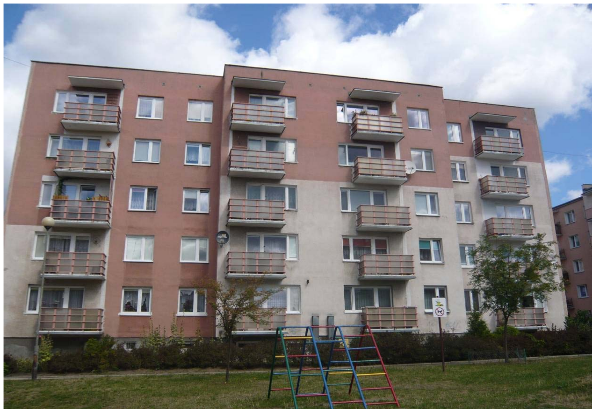
FOT.1. Widok na fragment elewacji z balkonami, balustrady metalowe, z płytą przezierną.
