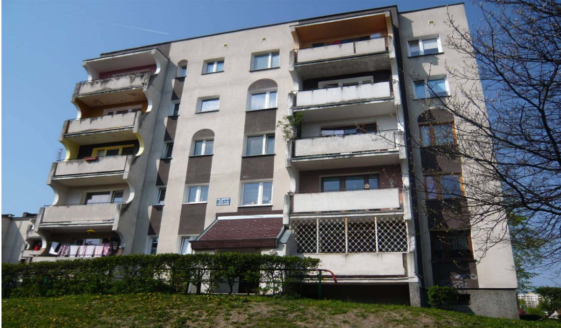
FOT.1. Widok na fragment elewacji z balkonami, balustrady z płyt betonowych.
