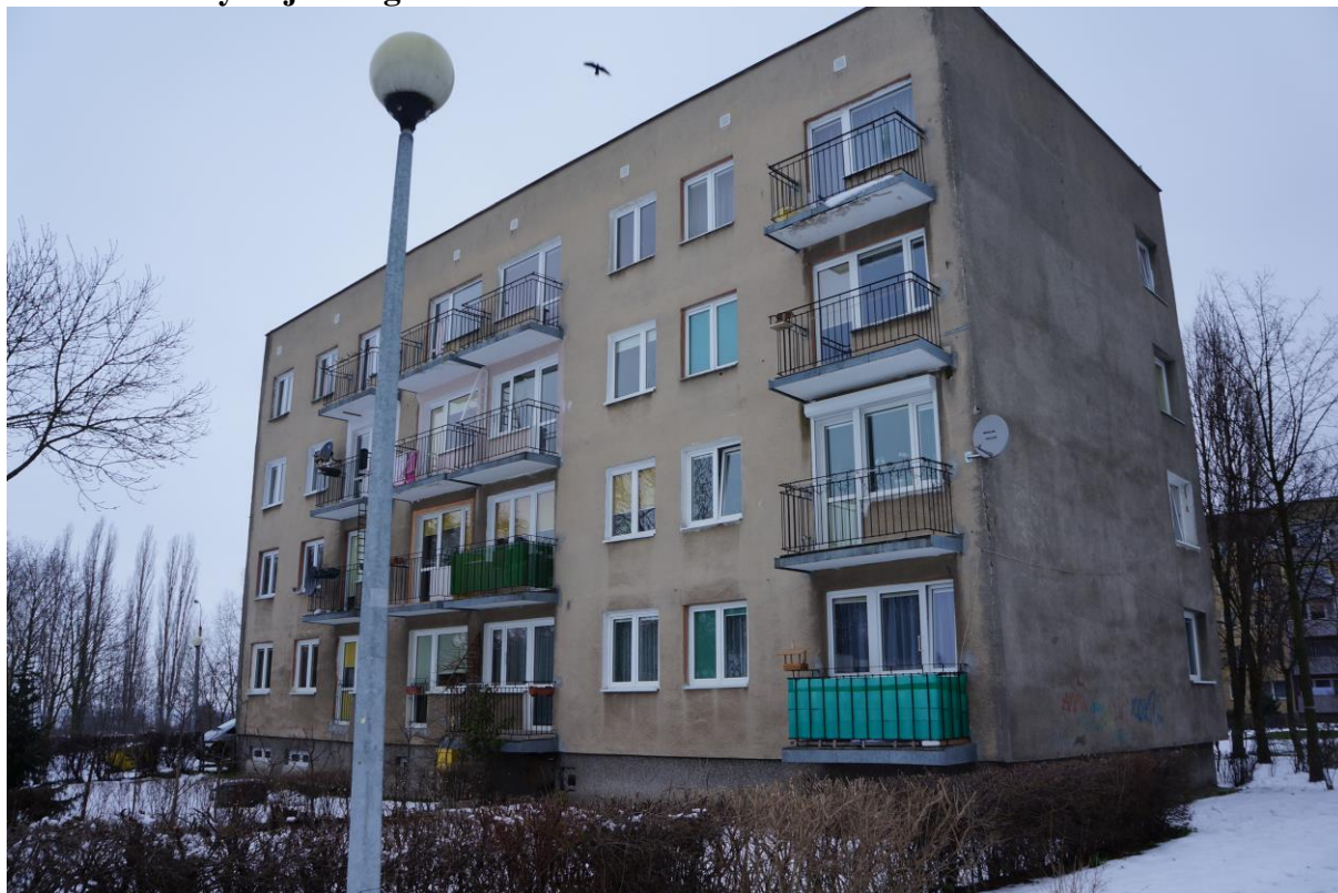
Fot.1., 2. Widok na fragment elewacji z balkonami, balustrady metalowe, ażurowe.
