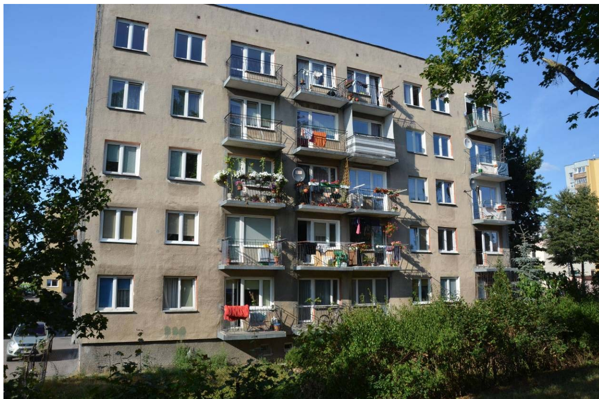
FOT.1. Widok na fragment elewacji z balkonami, balustrady metalowe, ażurowe.
