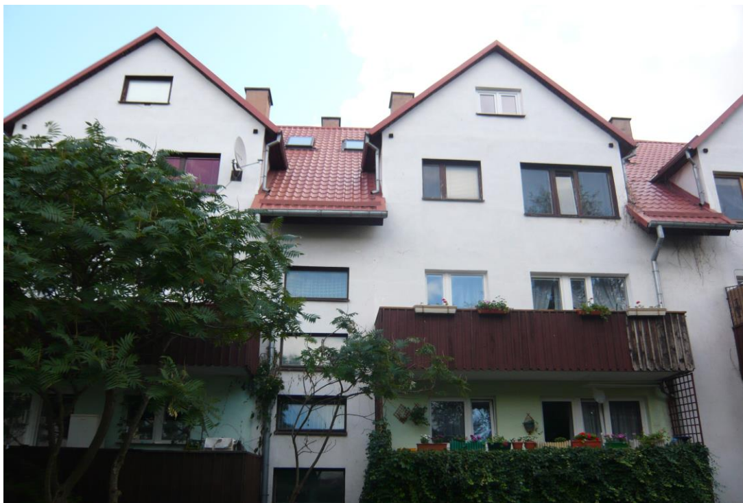
Fot.3. Widok na elewację tylną (zachodnią).
