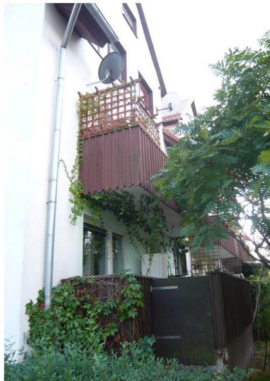
Fot.6. Widok od strony północnej na tarasy i balkony.
