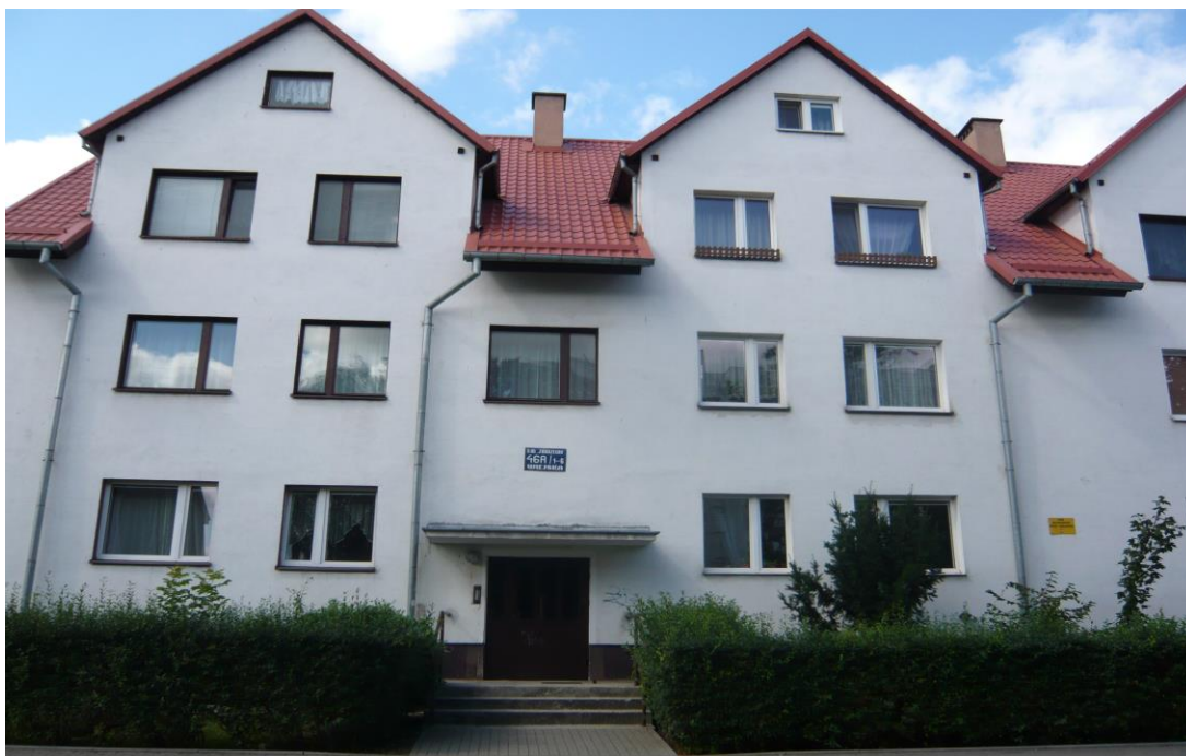
Fot.2. Widok na wejście do klatki schodowej – elewacja frontowa.
