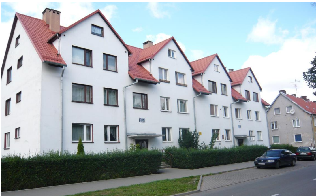
Fot.1. Widok na elewację frontową (wschodnią).
