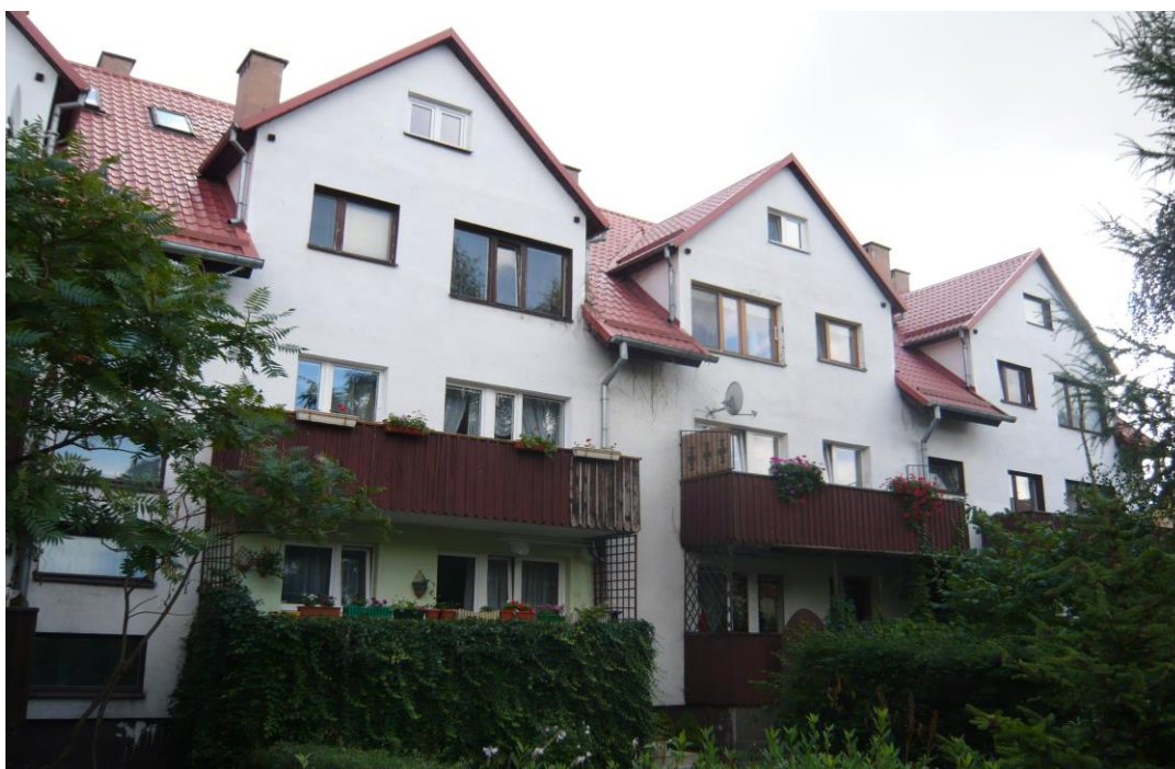
Fot.4. Widok na balkony – elewacja tylna (zachodnia).
