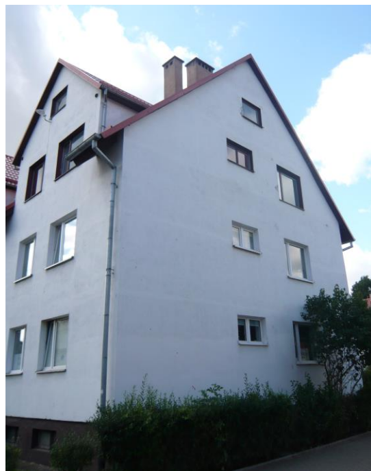
Fot.8. Widok na elewację północną.
