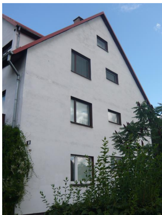
Fot.7. Widok na elewację południową.
