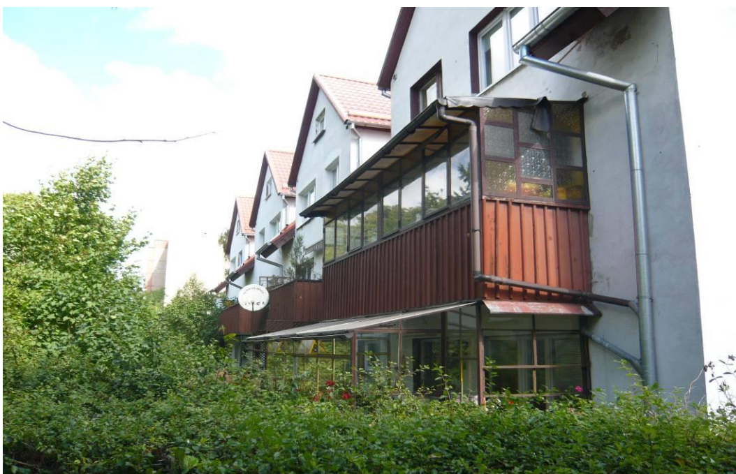
Fot.4. Widok na balkony – elewacja tylna (zachodnia).
