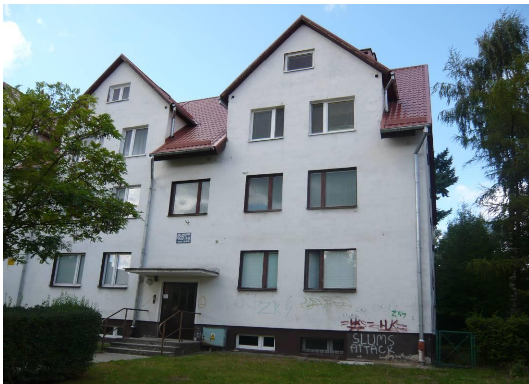
Fot.1. Widok na elewację frontową (wschodnią).
