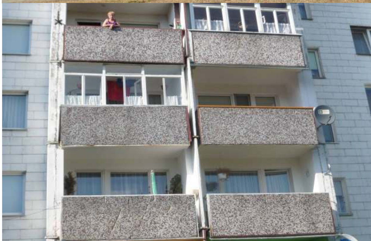
FOT.1.,2. Widok na fragm. elewacji z balkonami, płyty balustrad z wykończeniem strukturalnym.
