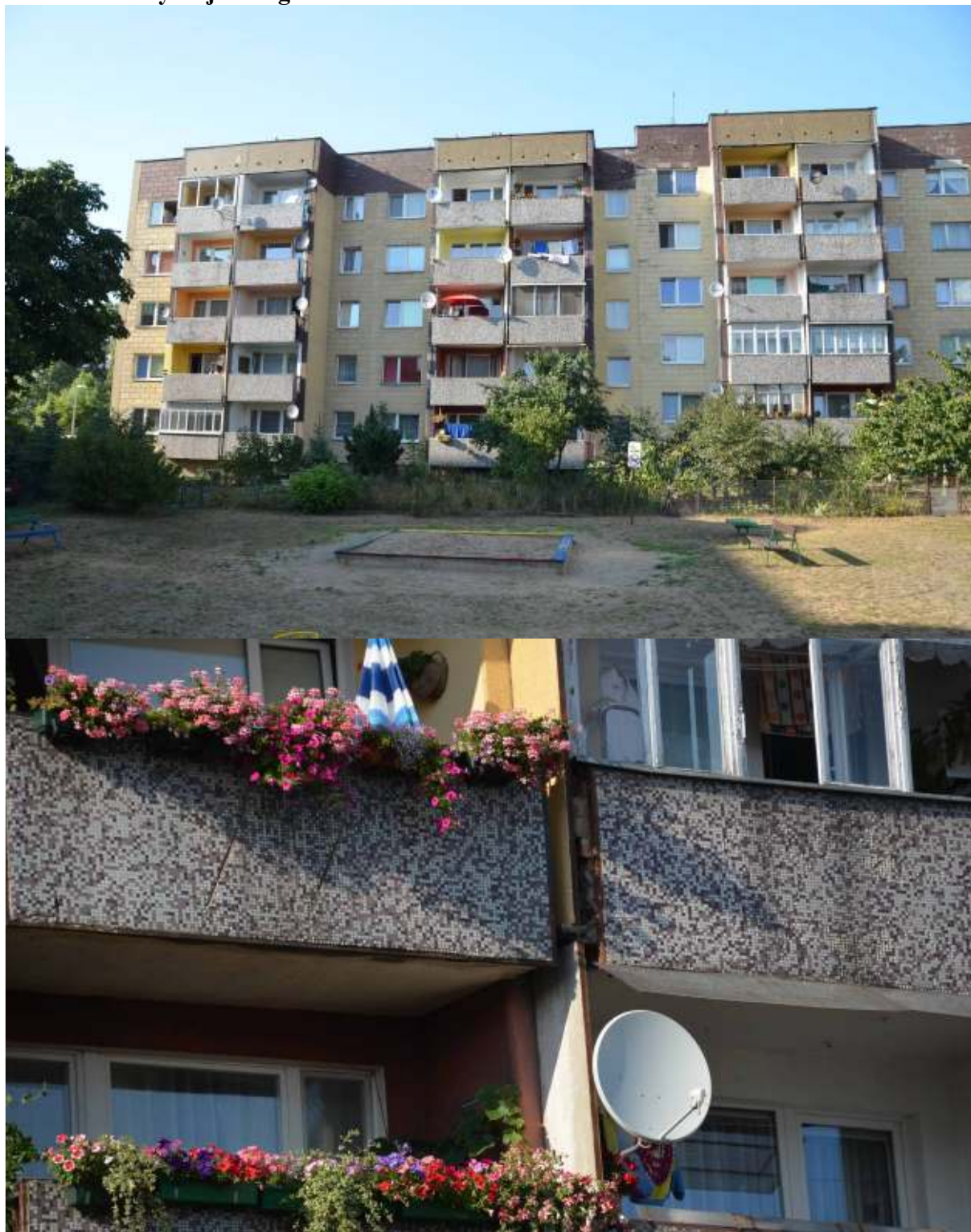
FOT.1.,2. Widok na fragm..elewacji z balkonami, płyty balustrad z wykończeniem strukturalnym.
