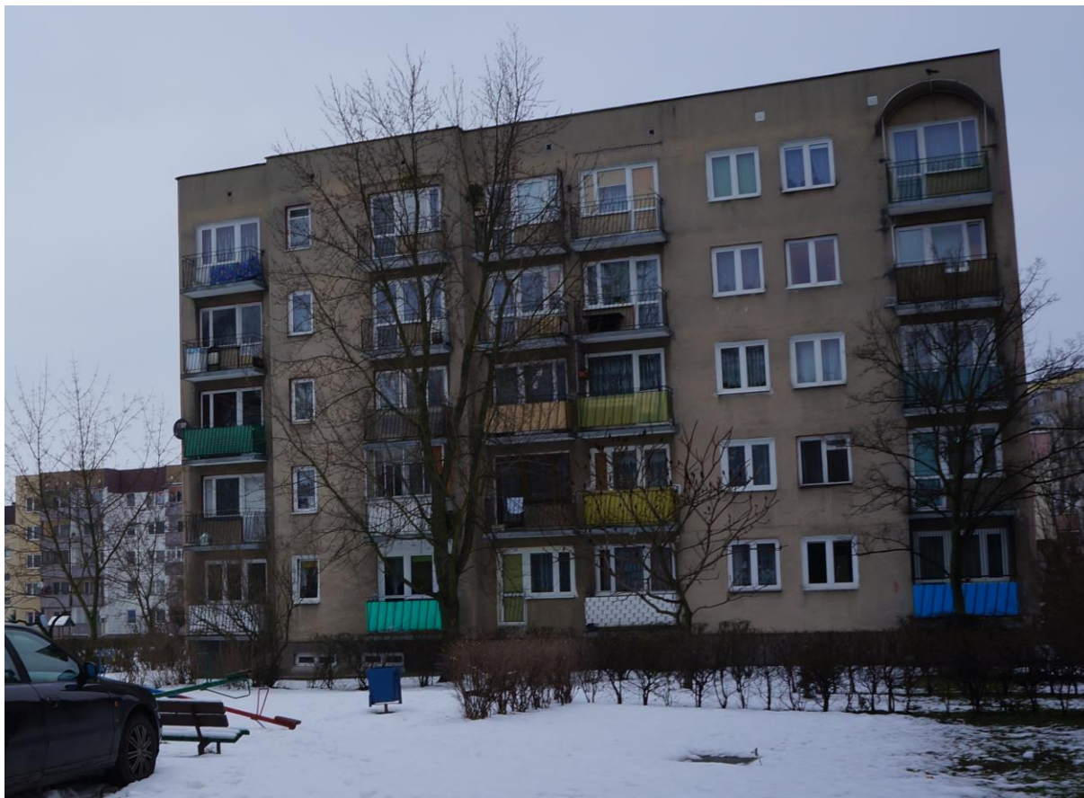
Fot. 1. Widok balkonów od strony zachodniej
