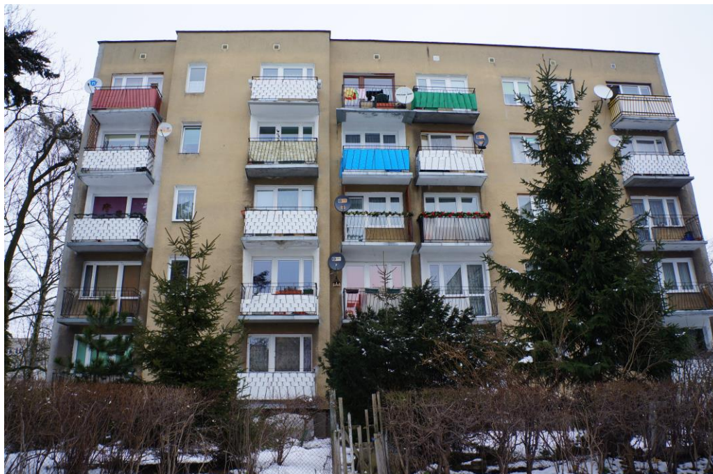
Fot. 1. Widok balkonów od strony południowej
